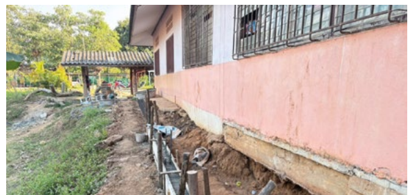
เสริมแนวปูนกันดินทรุดของอาคารห้องสมุดและห้องเรียนอนุบาล
